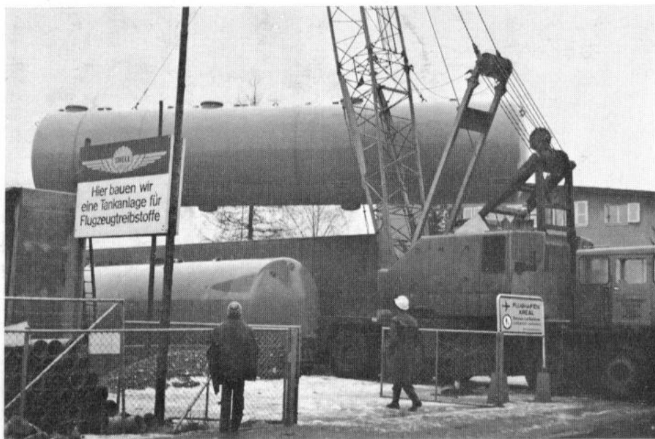
Oktober 1970: Einbau der zwei 100000-Liter-Behälter für Flugzeugtreibstoffe in der Shell-Tankanlage
