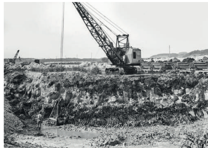
In 4,2 Metern Tiefe musste beim Pistenbau eine Seekreide- und Torfschicht ausgehoben werden.
