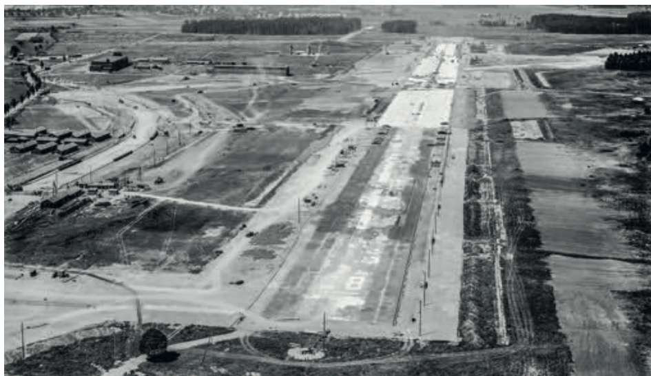
Der Bau der Westpiste und der Rollwege schritt zügig voran, wie dieses Bild vom 24. Juli 1947 zeigt.
