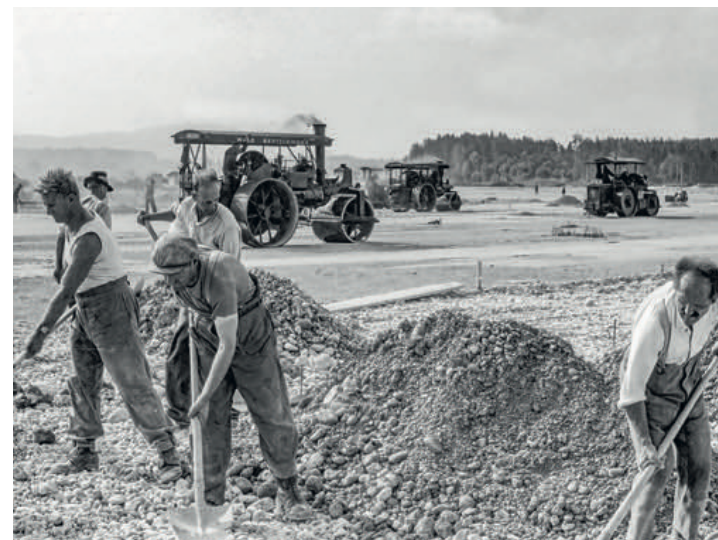
Beim Einbringen des Schotters für den Pistenuntergrund war im August 1947 viel Handarbeit gefragt. Zum Einsatz kamen Dampfwalzen von der Firma Walo Bertschinger zum Einsatz.
