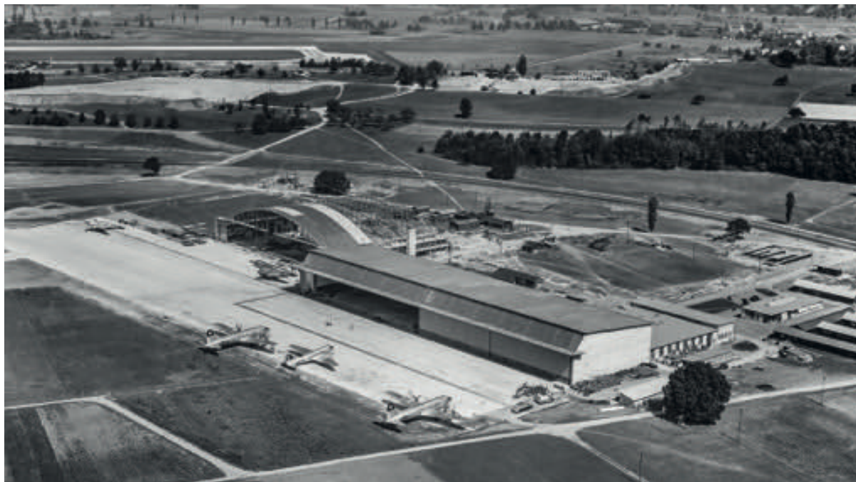
Der legendäre Bogenhangar entstand 1949 als damals grösste freitragende Konstruktion in der Schweiz, wie diese Aufnahme vom 5. September zeigt. Er ist als einziges Gebäude aus der Anfangszeit des Flughafens Zürich heute noch in Betrieb.
